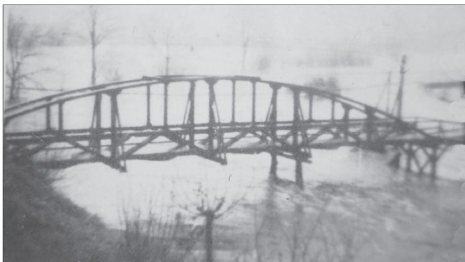
Hölzerner Brückensteg mit einer Breite von 1,5 Meter. Hochwasseraufnahme Januar 1932 Archiv Lothar Schreiter
