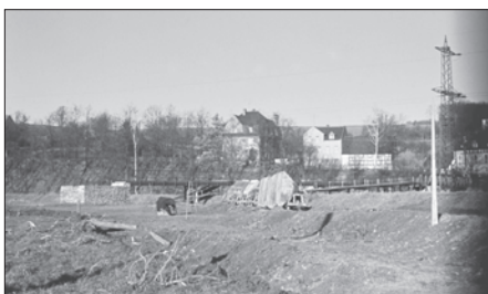
Rechts davon heutiger Freizeitpark um 1960. Die wiederum notwendige Anpassung zu dem neuen Damm ist schon im Bau. Die alte Rampe ist noch in Benutzung. Archiv Lothar Schreiter
