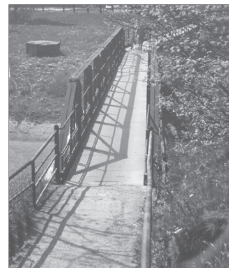
Die stählerne Brücke der zweiten Generation von 1939 bis 1994. Bilder undatiert. Archiv Lothar Schreiter
